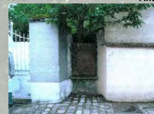
22 rue Pierre Bezaçon Ancien puits – Parcelle AN 172
